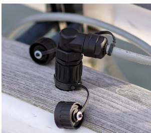
[bild 4] Genomföringskontaktarna installerade på båten
